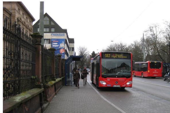
Abbildung 18: Haltestelle „Postgraben“ – kein niederflurgerechter Ausbau, Bus kann deshalb nicht spaltfrei an den Bordstein anfahren
