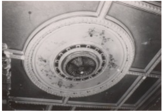
Beschädigte Stuckdecke (70er Jahre)
