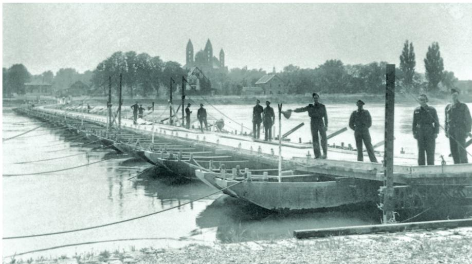
*Zwischenlösung: Nach der Sprengung der Rheinbrücke 1945 bauten die Franzosen eine Pontonbrücke über den Rhein..*
