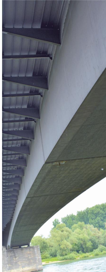
*Massiver Koloss: 4900 Kubikmeter Beton sind in der Salierbrücke verbaut.*
