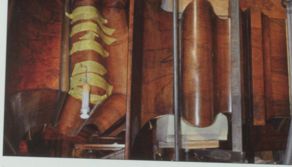
Auch an der Holzarchitektur waren viele Ausbesserungsarbeiten notwendig. So zum Beispiel das neue Verleimen gelöster Teile. Foto: M. Recker
