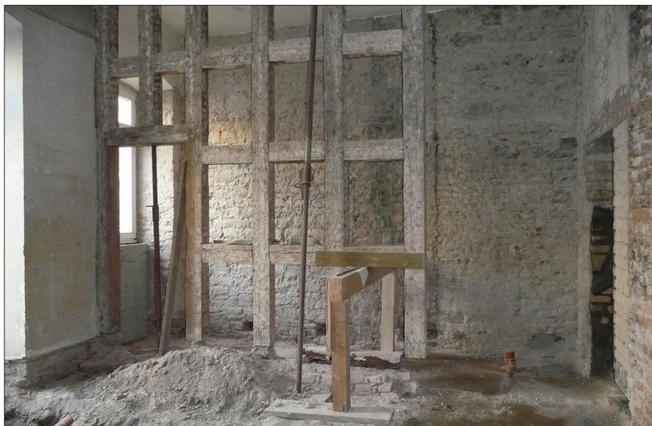
*In den Rohbau zurückgeführt wurden die Innenräume des Bischofshauses. Statische Probleme bei den Decken und Feuchtigkeit müssen beseitigt, neue Heizungs-, Wasser- und Elektroinstallationen eingebaut werden. Foto: Bischöfliches Ordinariat*
