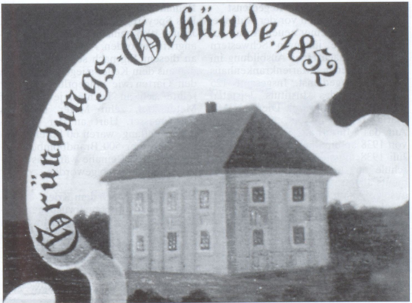
Bild des Mutterhauses „Gründungsgebäude“ im Jahr 1852
