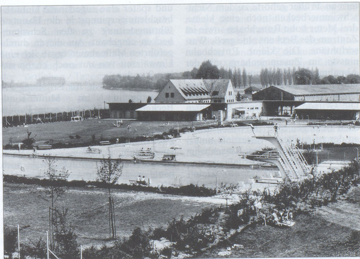
Das Freibad 1956 vom Rheindamm aus fotografiert. Heute ist dieser Einblick durch große Bäume versperrt. Foto: Flaschenträger
