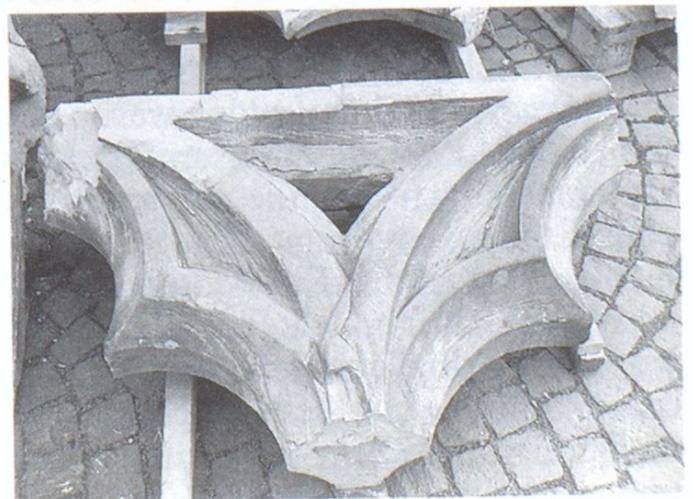
**Schwer beschädigtes Maßwerk. Der Stein musste ausgetauscht werden.**
