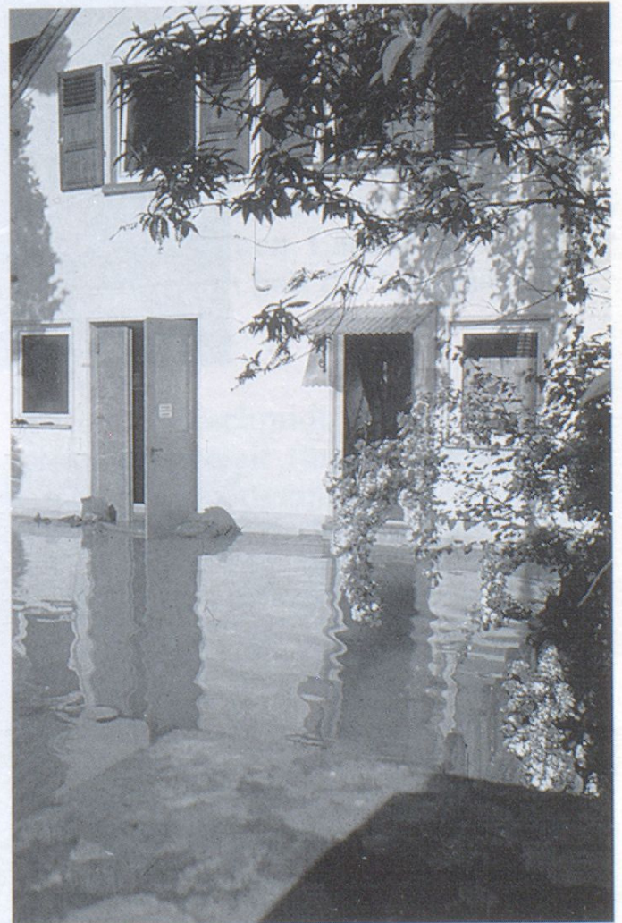
Vom Hochwasser im Mai betroffen waren die Bewohner dieses Hauses.
