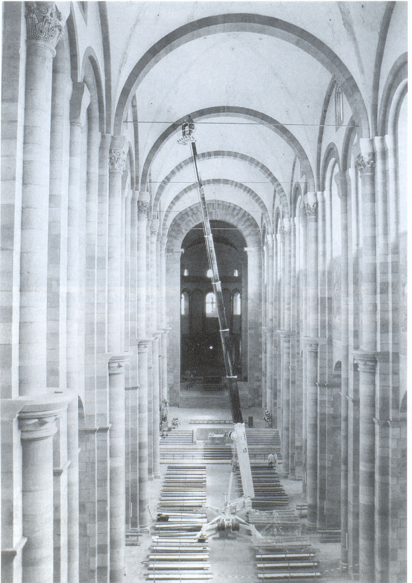
Gewölbeuntersuchungen im Frühjahr 1996 mit Hilfe einer großen Hebebühne, auch Spinne genannt.
