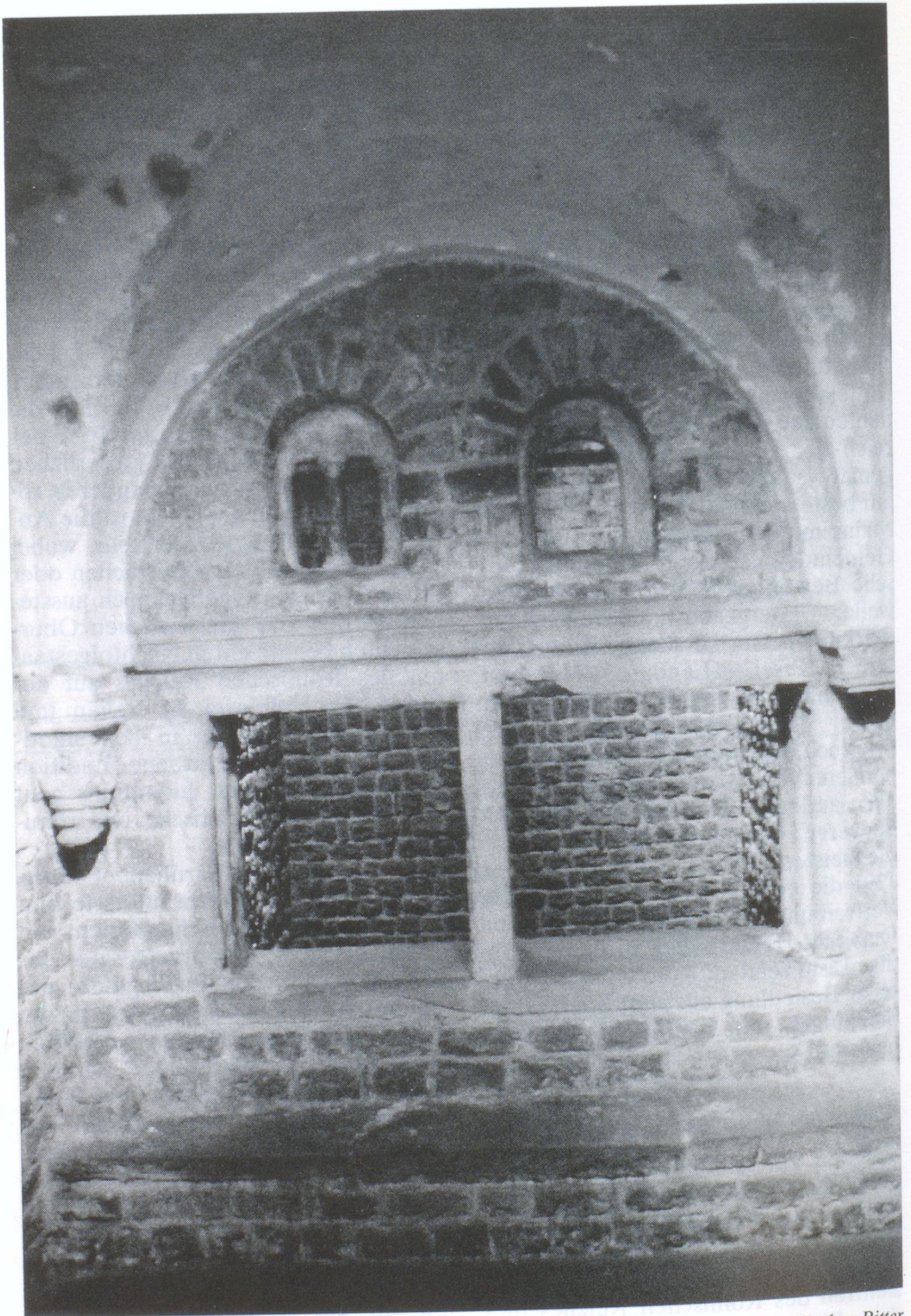
Fenster im Vorraum zum Badeschacht.
