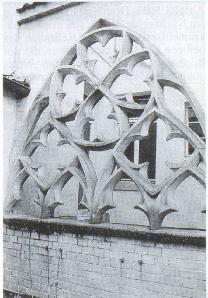
Speyer, Ludwigstraße 49. Gotischer Maßwerkbogen, angeblich aus dem Bereich der St.-Guidostiftskirche, um 1930 versetzt.
