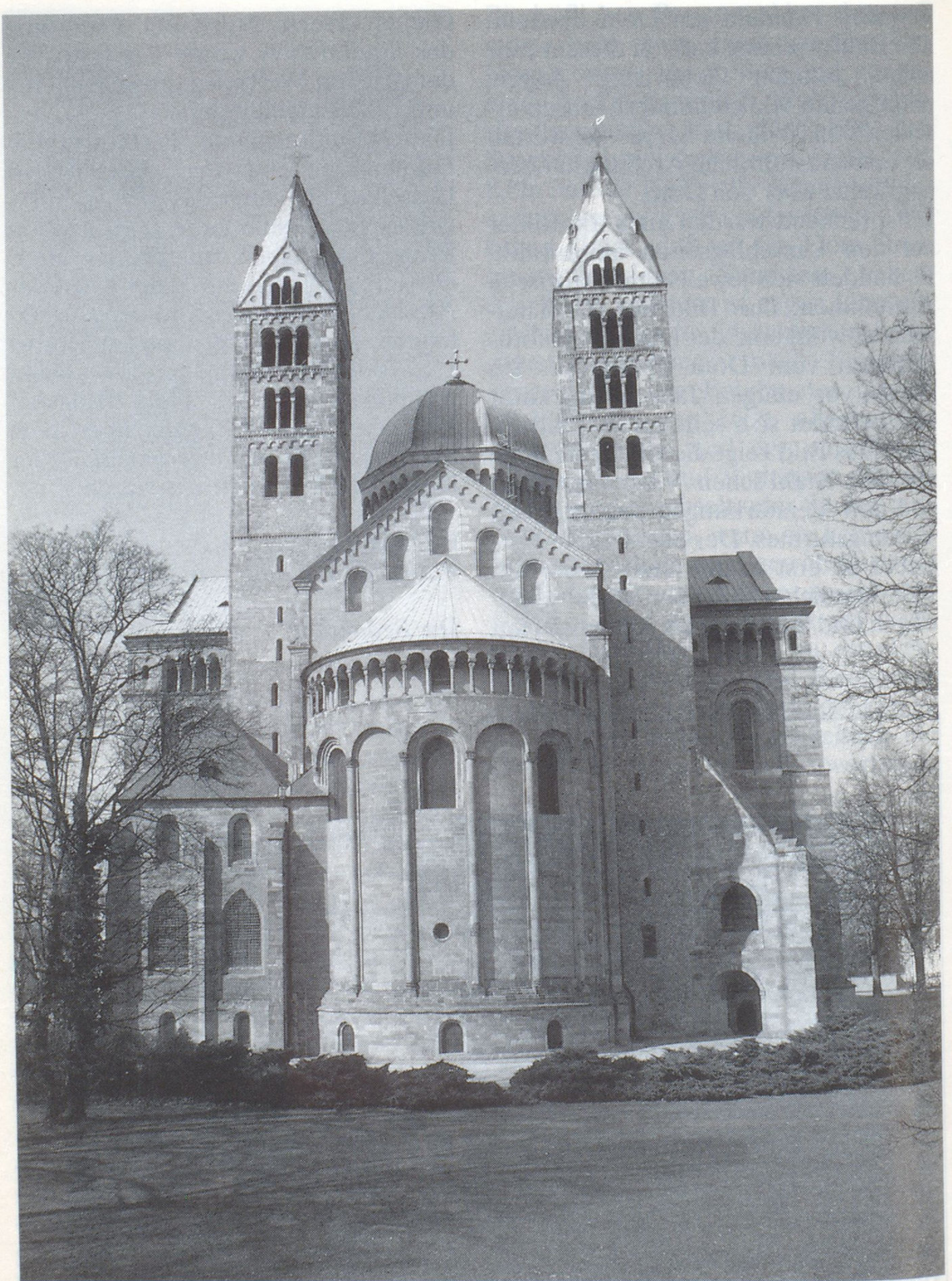
Der Ostbau des Domes in stilreiner Romanik mit dem tiefergelegten Dach und den rekonstruierten Giebeln. Links die gotische Sakristei von 1409, rechts der von Stahl errichtete Stützbogen, um die besonders gefährdete Ecke des Nordostturmes gegen die Bischofspfalz abzustreben.
