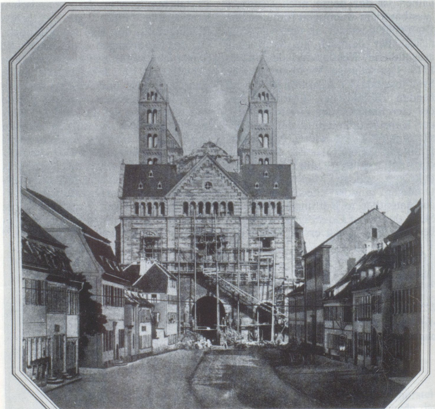
Der Westteil des Domes befindet sich noch – über dem noch erhaltenen romanischen Erdgeschoß – im Bau, der Glockenturm ist erst im Ansatz vorhanden. Das Foto entstand um 1855.
