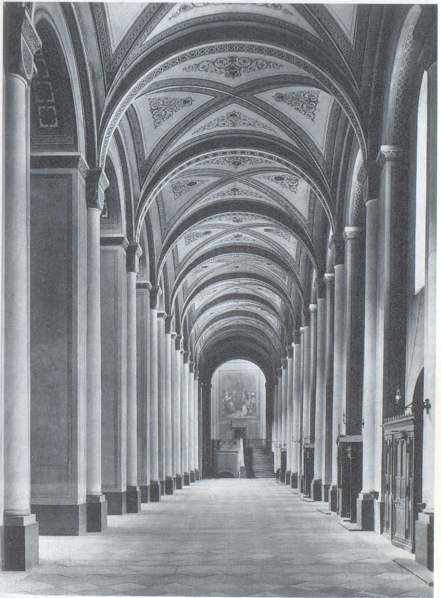
Das Innere des südlichen Querhauses vor der Abnahme von Putz und Dekorationsmalerei. Im Hintergrund ein Blick in den Stephanschor mit einem Bild, das den Märtyrertod des hl. Papstes Stephanus darstellt. Die drei Bildtafeln des Stephanszyklus sollen bald in den Kaisersaal verbracht werden.
