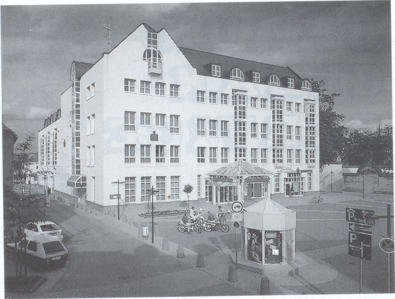
Unser Hauptstellegebäude in Speyer am Siebertplatz mit Autoschalter, Geldautomat und 100 öffentlichen Parkplätzen
