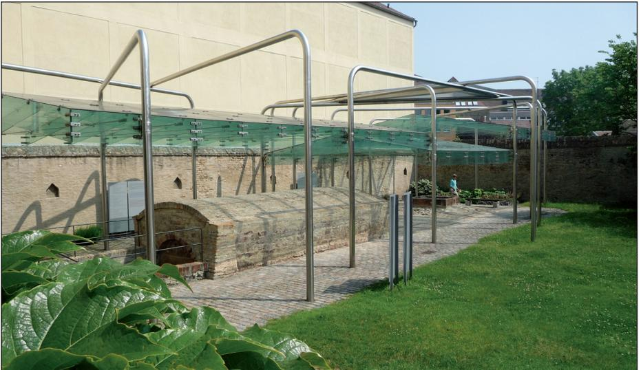
*Die leichte Glas-Stahl-Konstruktion der Überdachung ermöglicht es, dass der Blick frei über den Mikwe-Komplex schweifen kann. Foto: Jansky*
