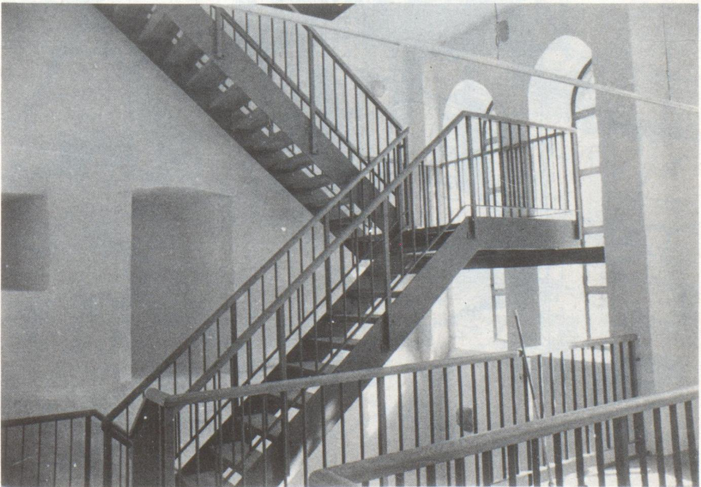
Für das nächste Jahr herausgeputzt wurde auch das Innere des Altpörtels. Die bisherige Holztreppe wurde aus Sicherheitsgründen durch eine Stahlkonstruktion ersetzt. Die gesamte Innensanierung des historischen Torturmes kostete rund 550 000 Mark.
