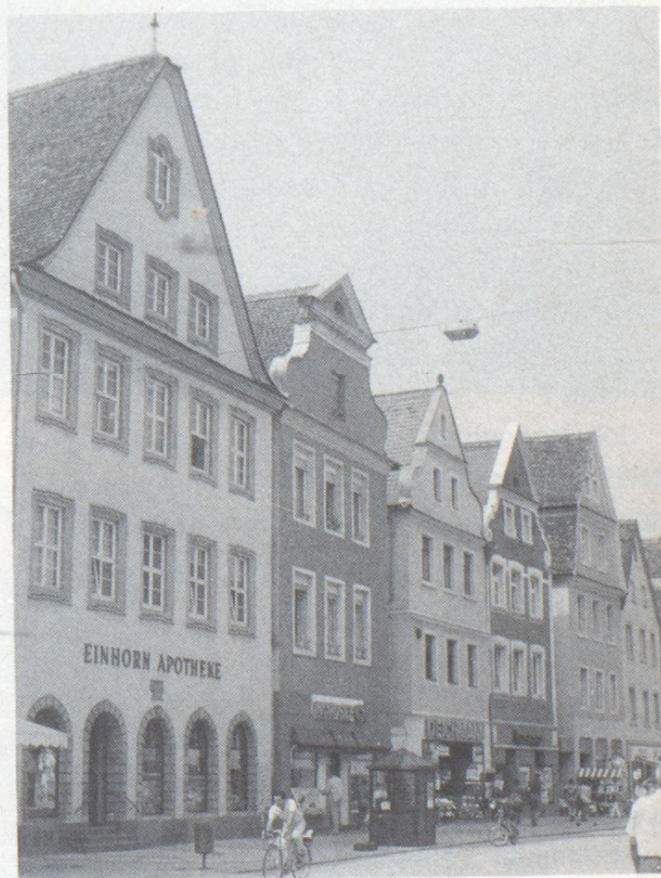
Historische Häuserzeile auf der Hauptstraße (Maximilianstraße 23 bis 28). Die ersten drei Häuser (von links) wurden 1703/1704 errichtet. Die Häuser Nummer 26 und 28 entstanden bereits 1699/1700. Etwas jünger ist Haus Nummer 27. Es wurde erst im zweiten Jahrzehnt des 18. Jahrhunderts errichtet.
