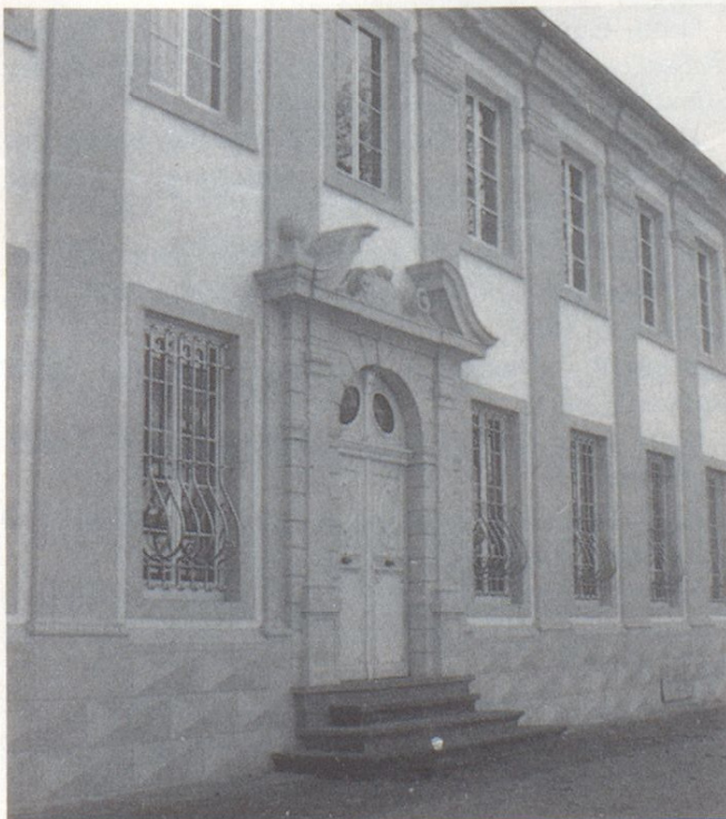
Das spätbarocke Palais in der Großen Pfaffen- gasse 13 wurde um 1700 in einem parkartigen Gar- ten errichtet.
