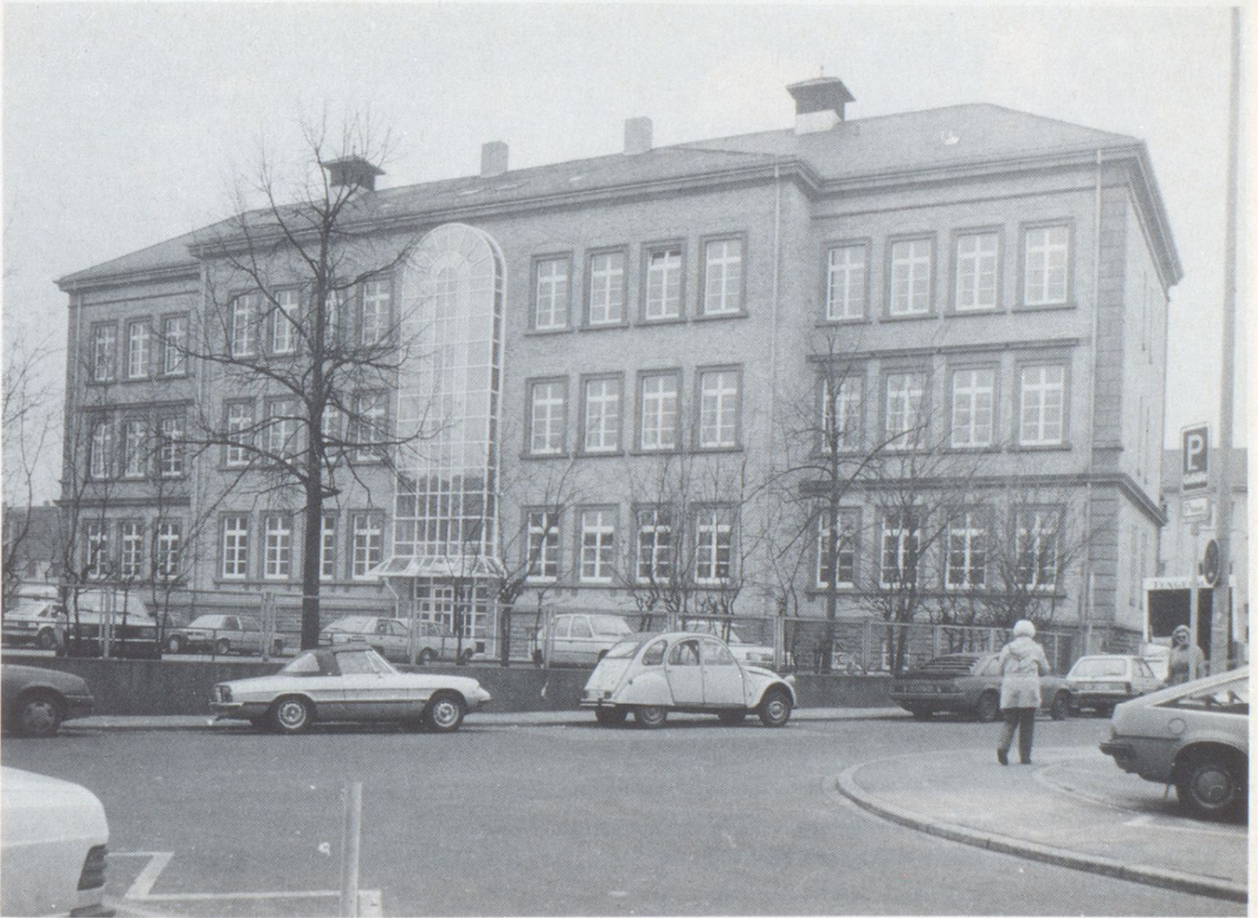
Seit 1. Januar 1987 heißt die ehemalige Roßmarktschule „Bodelschwingh-Haus“. Nach umfangreichen Umbauarbeiten dient das frühere Schulhaus jetzt der Evang. Kirche der Pfalz als Verwaltungsgebäude.
