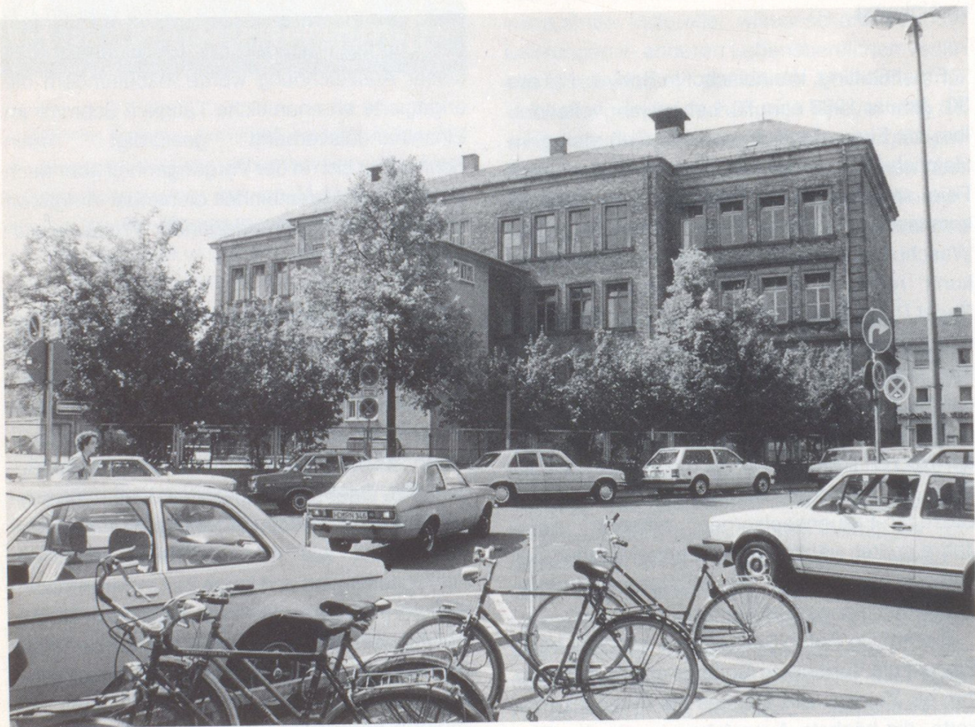
Rückseite der Roßmarktschule vor dem Umbau.
