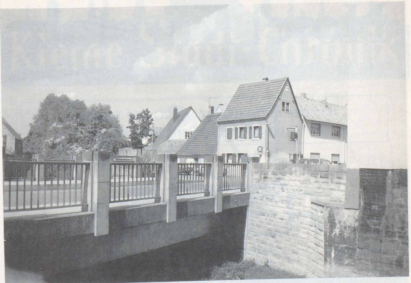
Die Salzturmbrücke nach ihrem Neubau im Jahre 1977. Maßgebend für die Erneuerung waren nicht nur Gründe der Verkehrssicherheit, sondern auch die gebotenen Maßnahmen zum Schutz vor Hochwasser.
