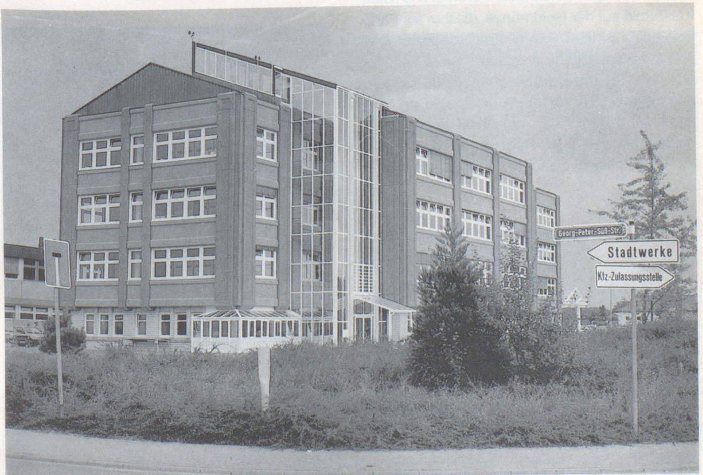
Das neue Verwaltungsgebäude der Stadtwerke an der Georg-Peter-Süß-Straße.
