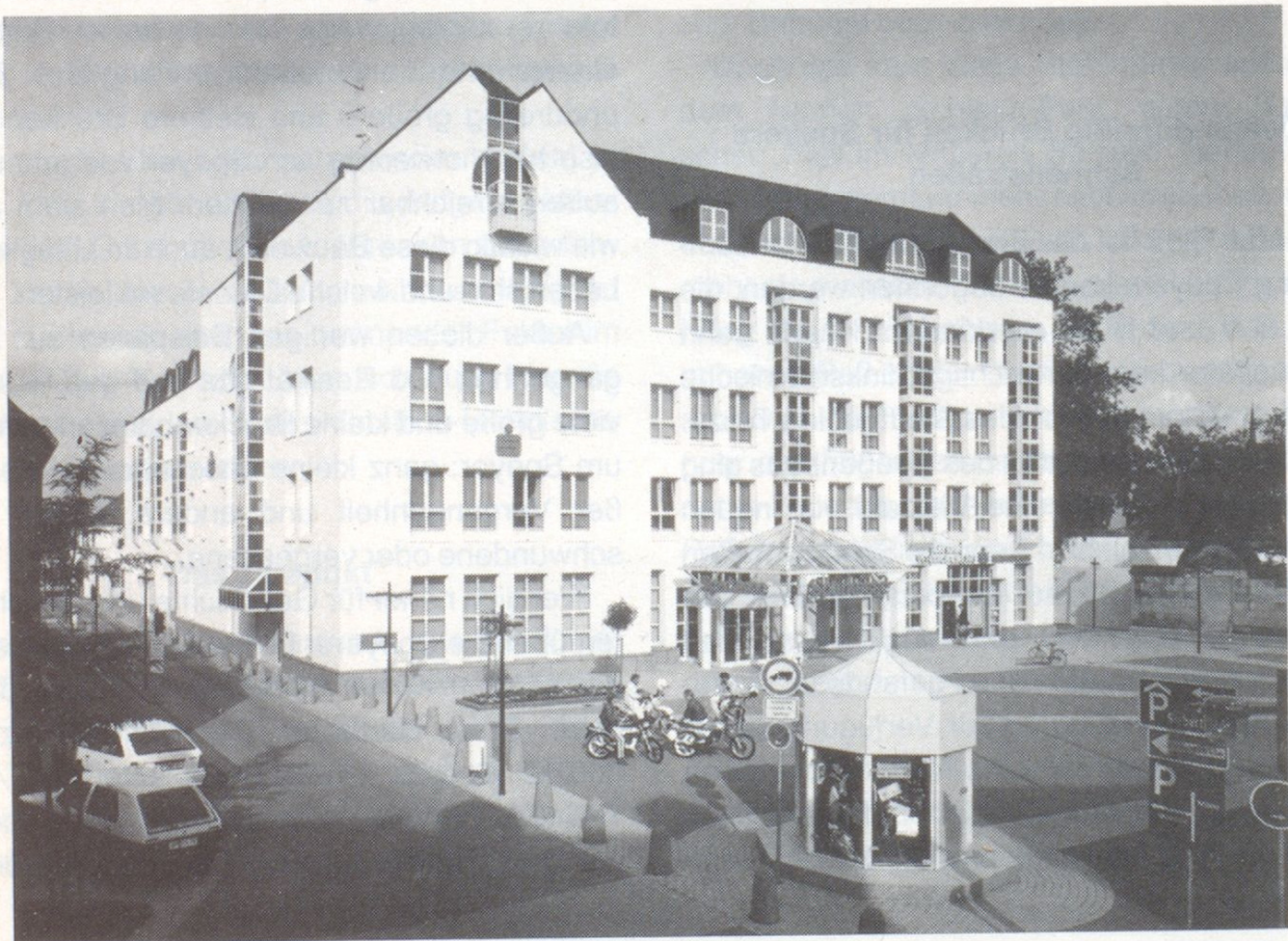
Unser neues Hauptstellengebäude in Speyer am Siebertplatz mit 100 öffentlichen Parkplätzen
