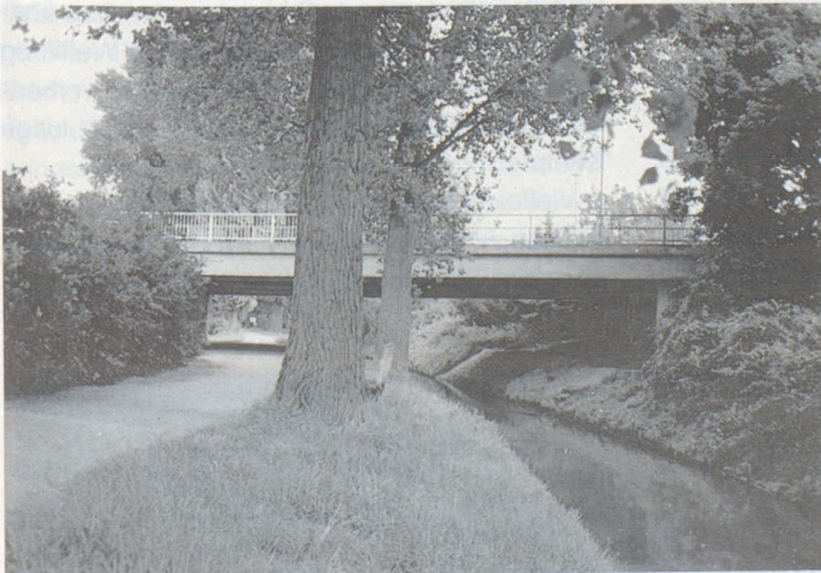
Brücke der Umgehungsstraße (B 9) über den Woogbach.
