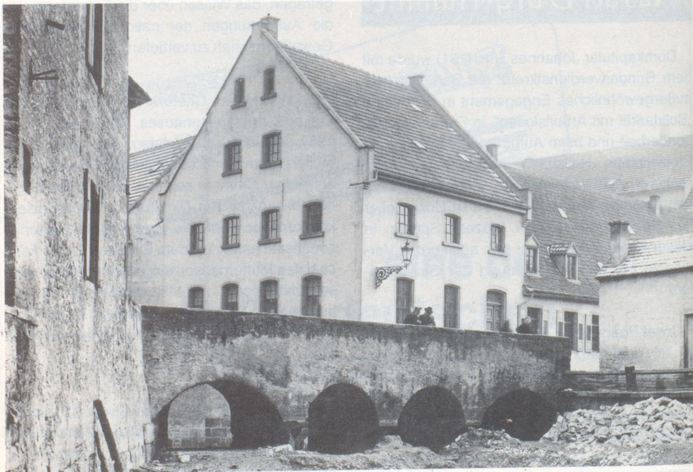
Bis zum Jahre 1910 überspannte die Salzturmbrücke mit vier Bögen den Nonnenbach im Hasenpflu. Danach wurde sie durch eine gemauerte Ein-Bogen-Konstruktion abgelöst.
