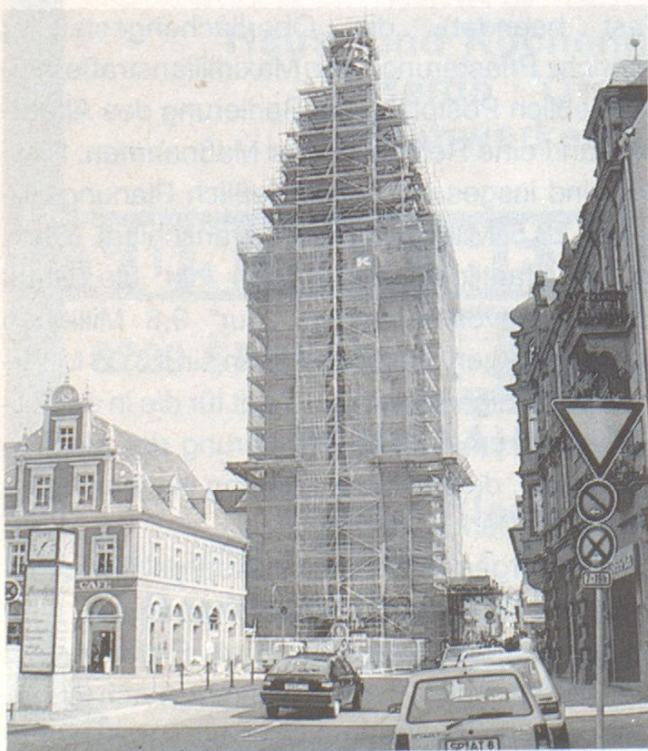
Das Altpörtel umgeben von einem Stahlgerüst.
