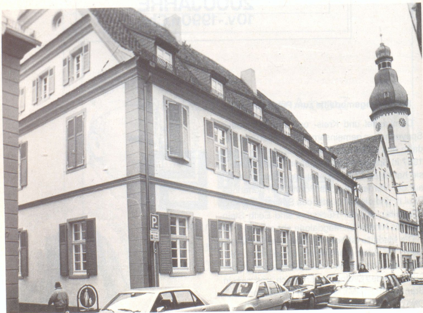
Anfang der 80er Jahre drohte den Anwesen Johannesstraße 28 und 29 der Abriß. Dank mutiger Privatinitiative blieben jedoch diese geschichtsträchtigen Häuser erhalten.
