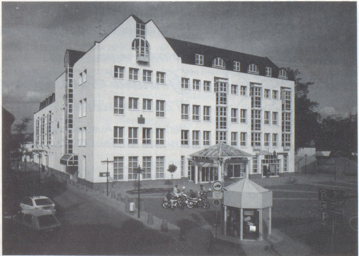
Unser neues Hauptstellengebäude in Speyer am Siebertplatz
