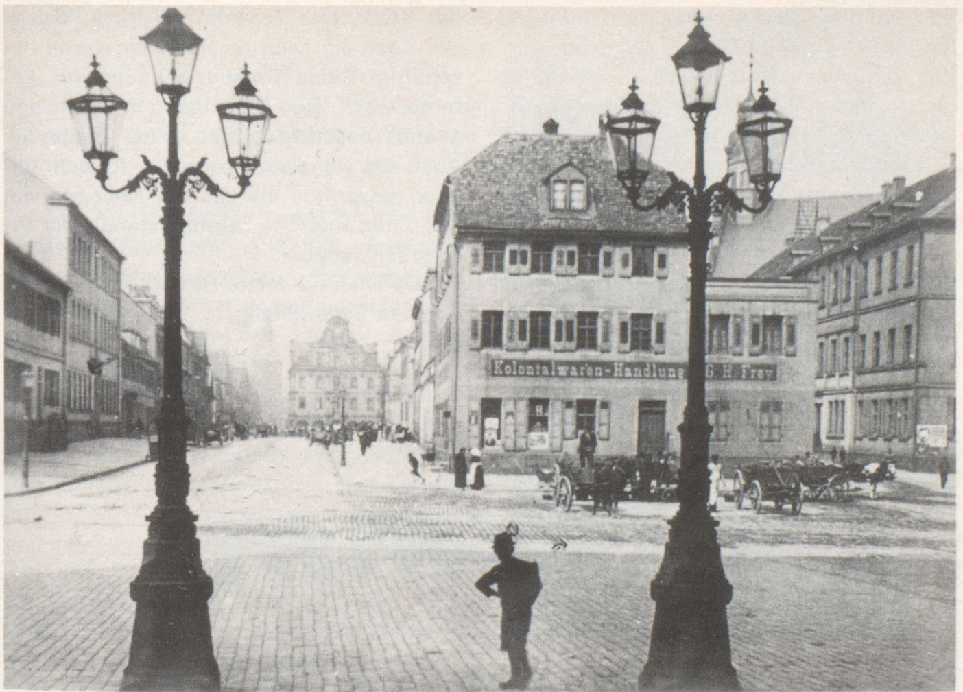
Romantisch sahen sie aus, die Kandelaber, die vor der Jahrhundertwende den Domvorplatz beleuchteten. Das Frey'sche Haus (rechts im Bild) wurde um 1900 abgerissen, um Platz für den Bau der Landesversicherungsanstalt zu schaffen.
