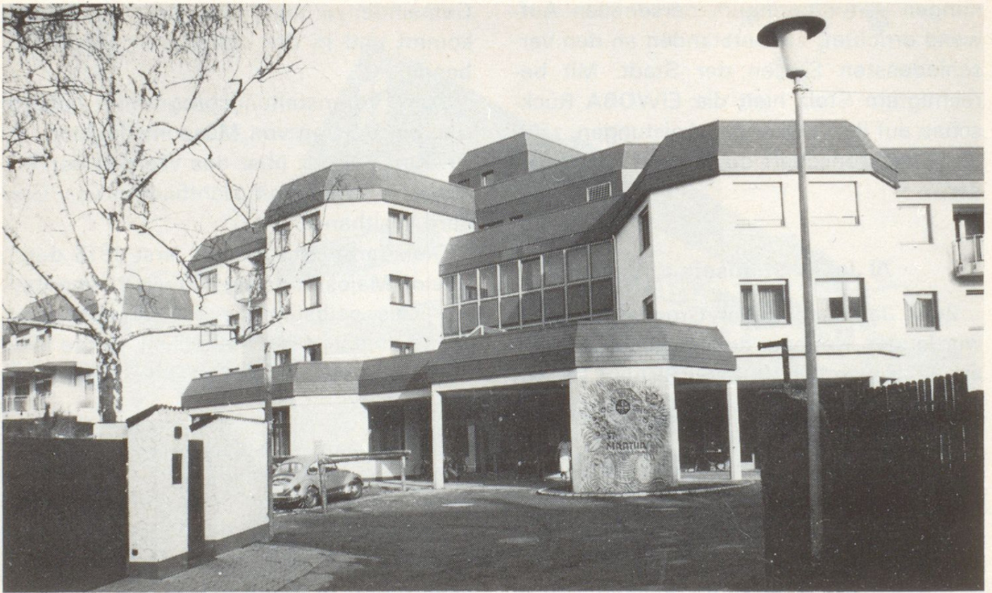
Hauptzugang zum neuen Altenwohn- und Pflegeheim St. Martha, von der Schützenstraße aus.
