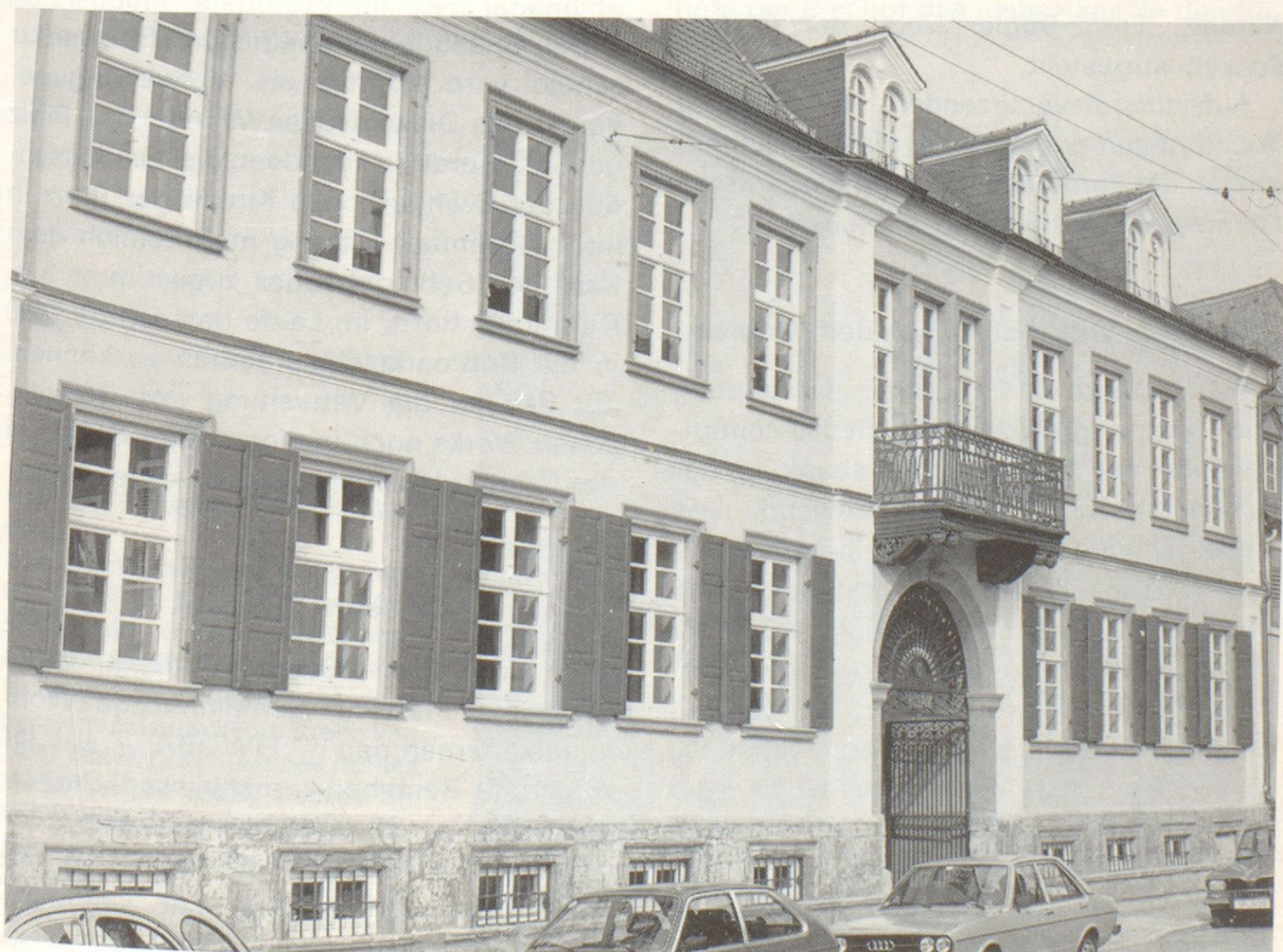
Das ehemalige Hospiz nach dem Umbau zu einem Studentenwohnheim.
