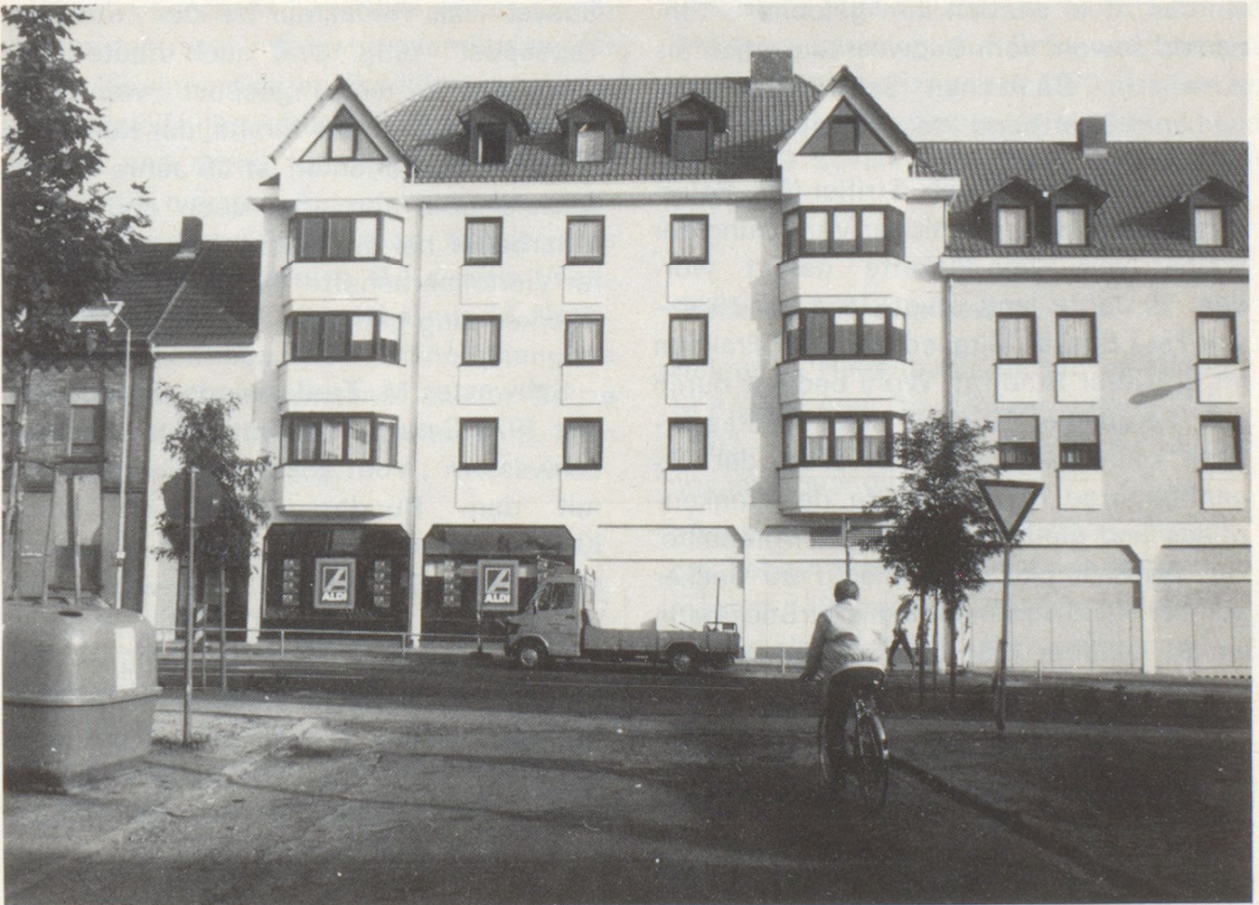
An dieser Stelle wurde bald danach ein modernes Wohn- und Geschäftshaus errichtet (November 1983).
