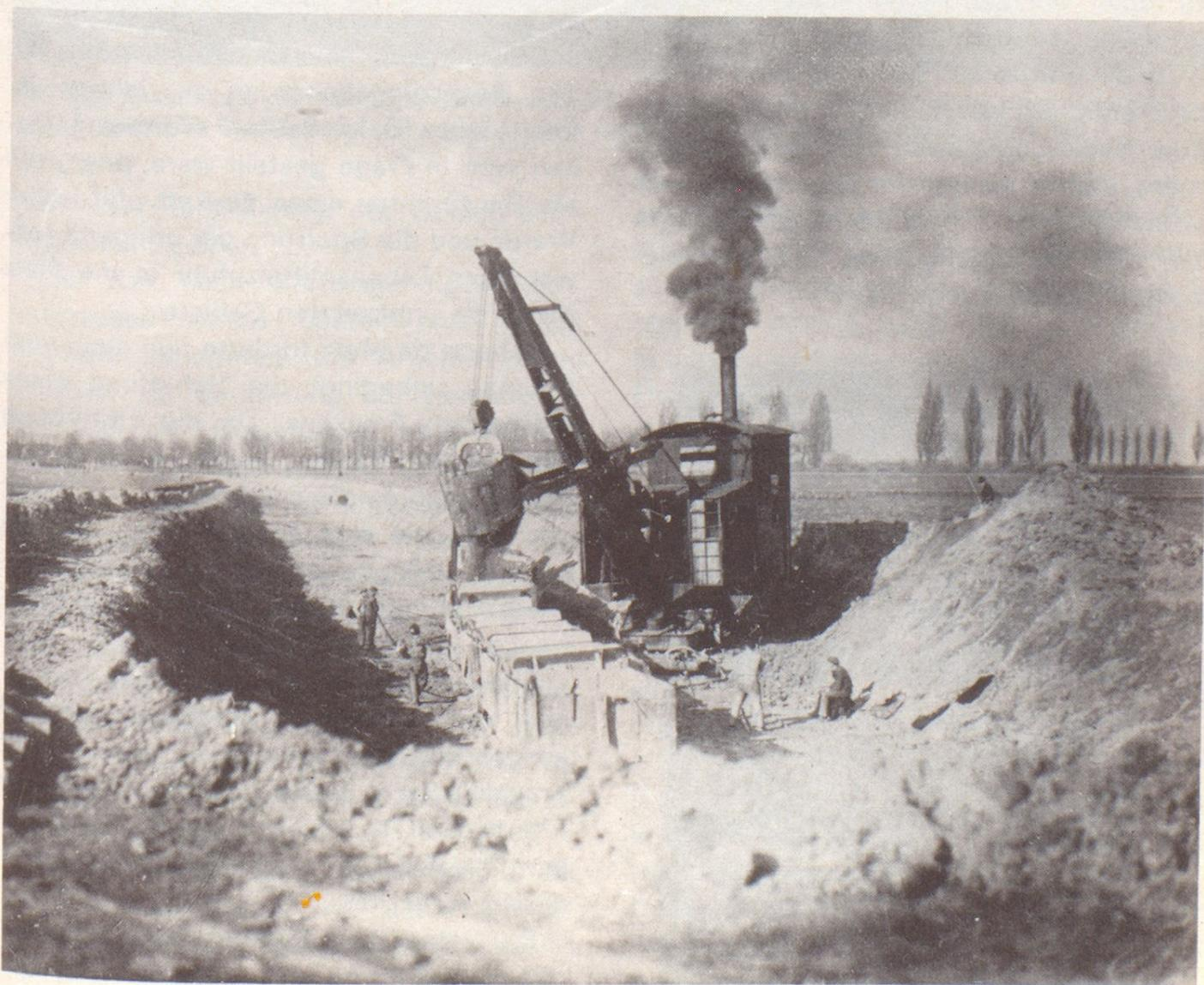
Notstandsmaßnahme „Hafenbau“; mit einem Dampf-Kran-Bagger wurden Loren beladen (25. 2. 1921).
