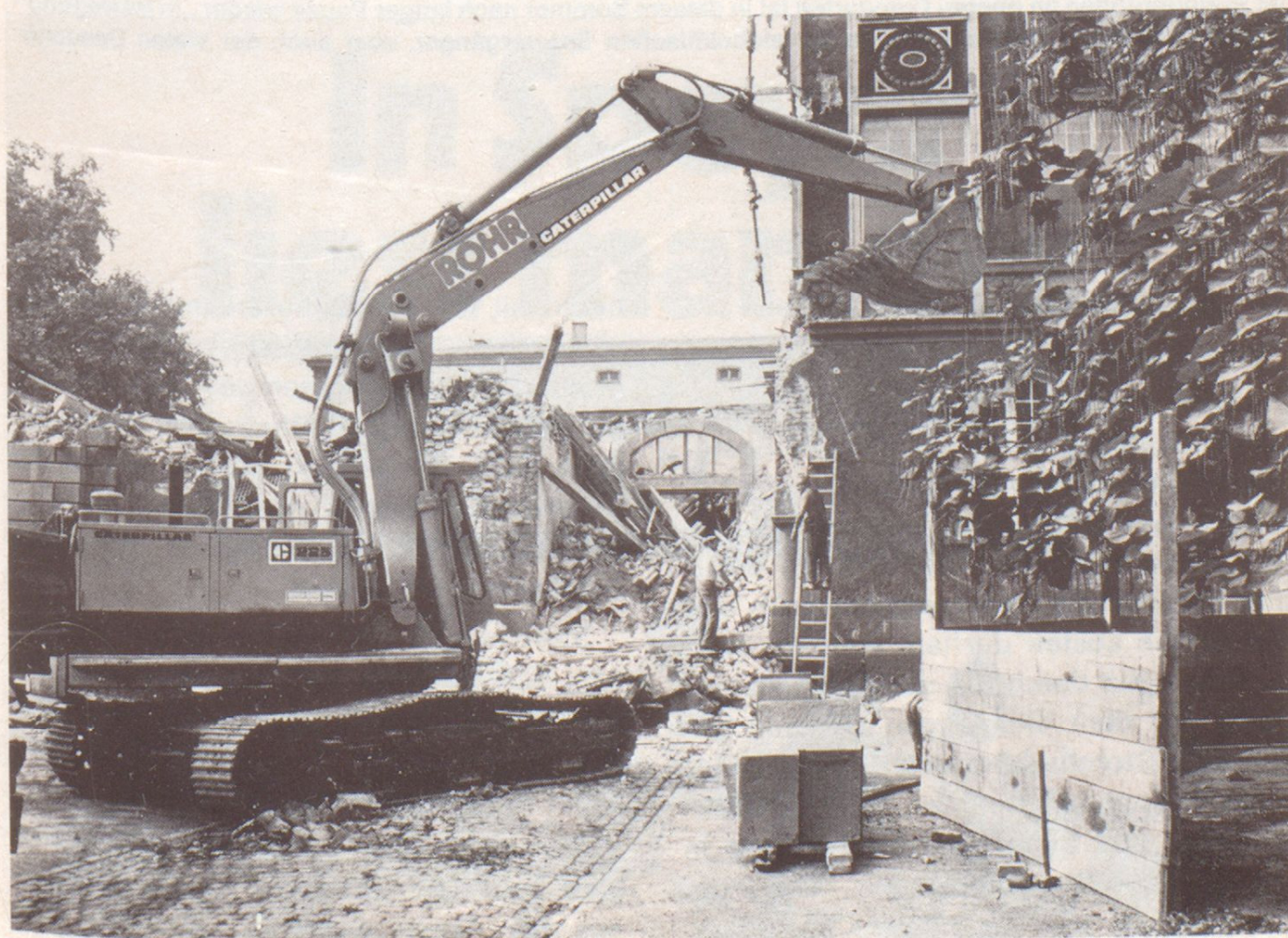
Mit einem schweren Bagger wird das alte Pestalozzi-Schulhaus „gefällt“.
