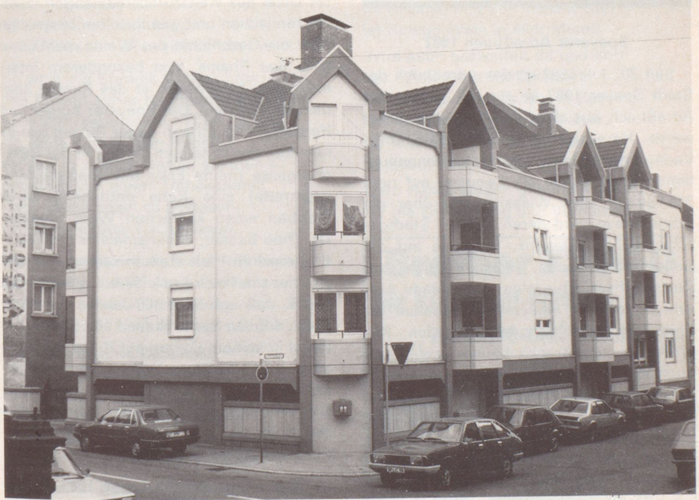
Bei dem von der Gemeinnützigen Wohnungsbau- und Siedlungs-GmbH Speyer (GEWO) an dieser Stelle errichteten Neubau war man sehr bemüht, auch städtebauliche Gesichtspunkte zu berücksichtigen (1982).
