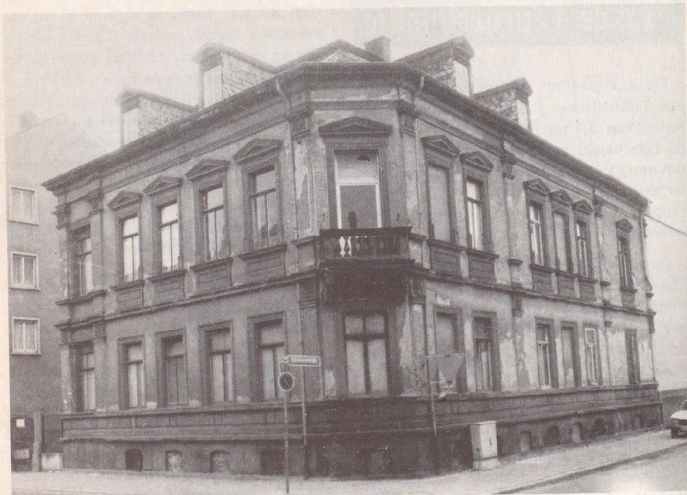
Das dem Zerfall preisgegebene Haus Roesinger wurde 1978 abgerissen.
