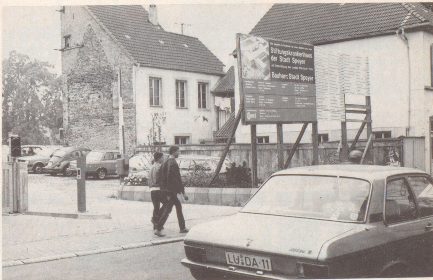
Der Zugang zum Stiftungskrankenhaus, von der Ludwigstraße aus. Noch steht die große Informationstafel an der Zufahrt, denn von der Baumaßnahme „Stiftungskrankenhaus“ wurde bis jetzt nur der erste Bauabschnitt vollendet (1981).
