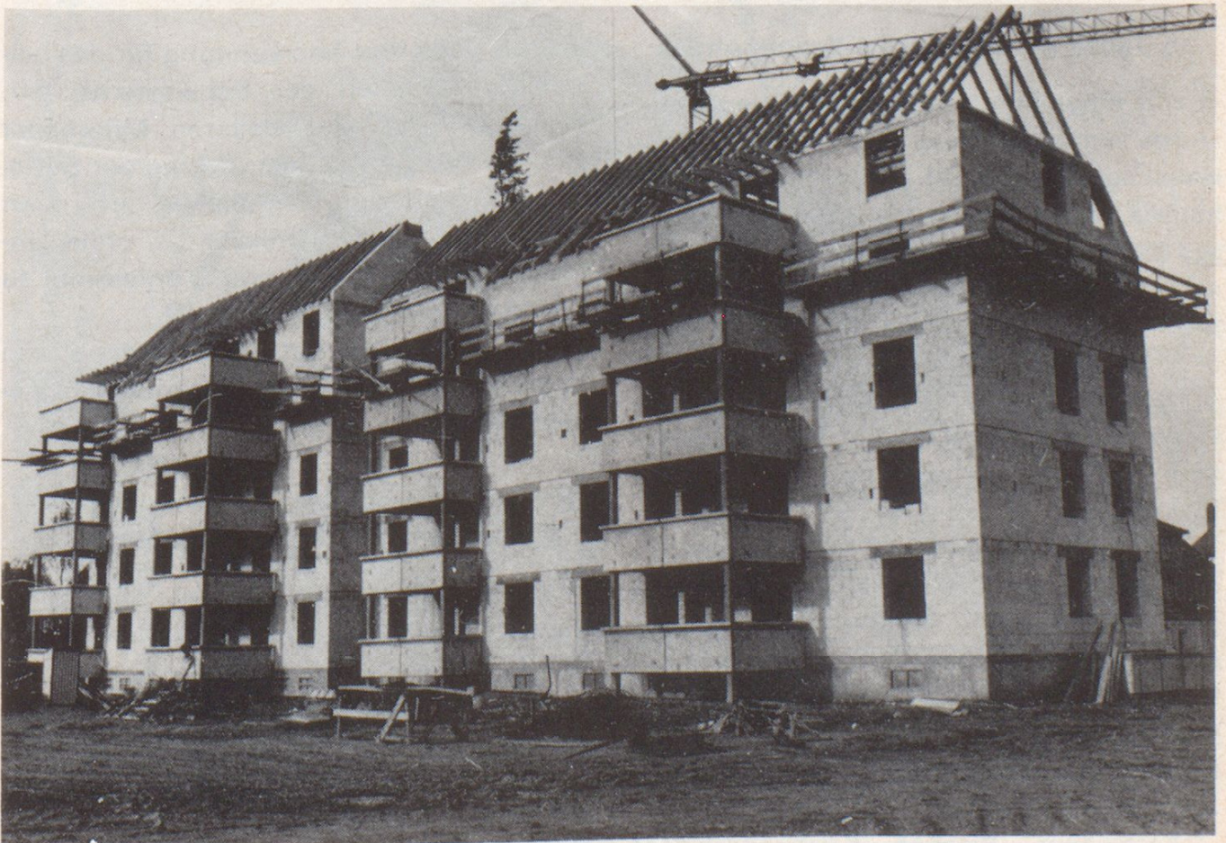
Der Rohbau des viergeschossigen Wohnblocks (Südseite); Zugang von der Josef-Schmitt-Straße.
