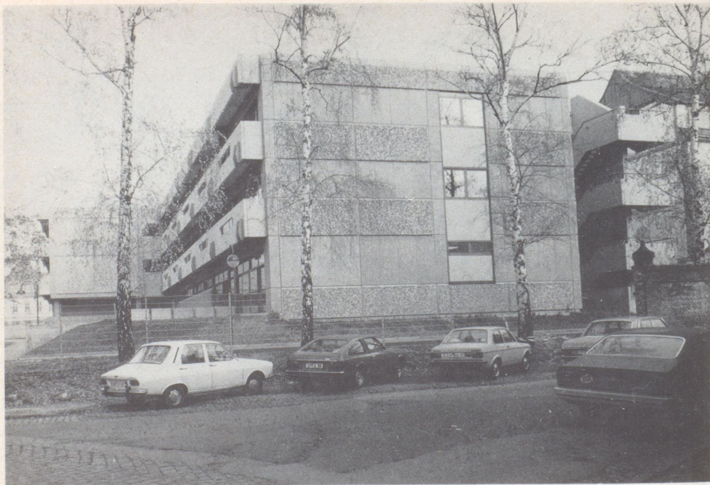
Der Neubau des städtischen Krankenhauses.
