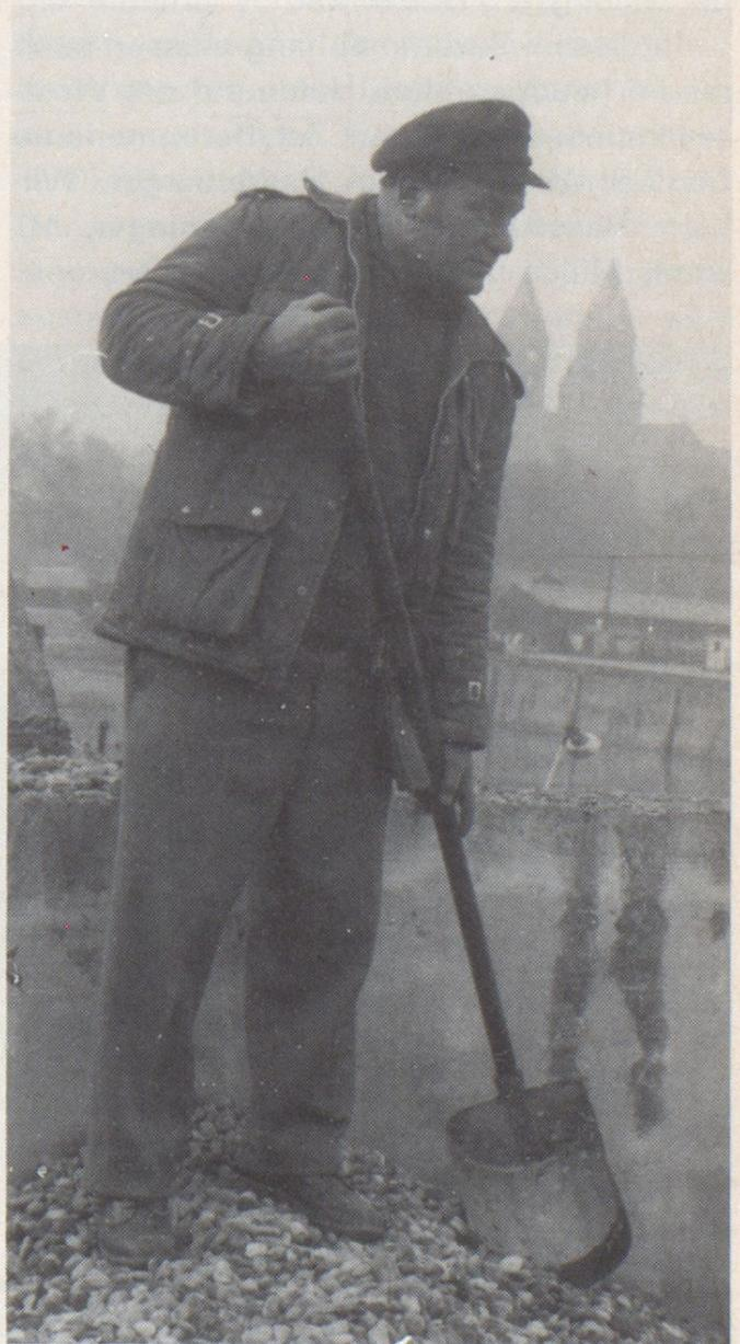
Mit einer solchen Kieskratze ging man bis Ende des 19. Jahrhunderts zu Werk, um Kies aus dem Rhein zu holen. Leistung pro Mann und Stunde mit diesem Gerät: etwa 1 bis 1,5 Kubikmeter.
