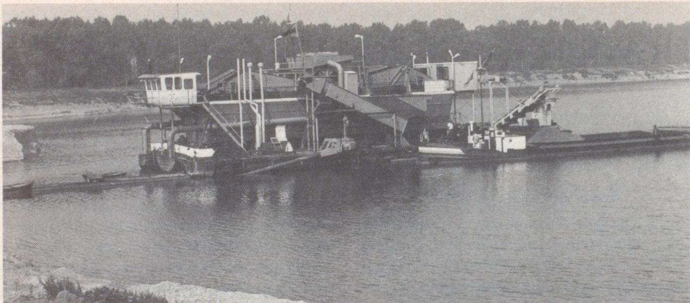
Saugbagger mit Silo P 7 (um 1960). Stundenleistung: Kiesaufbereitung 150 t; Verladung 500 t; Silo-Aufnahme 400 t sortiertes Material.
