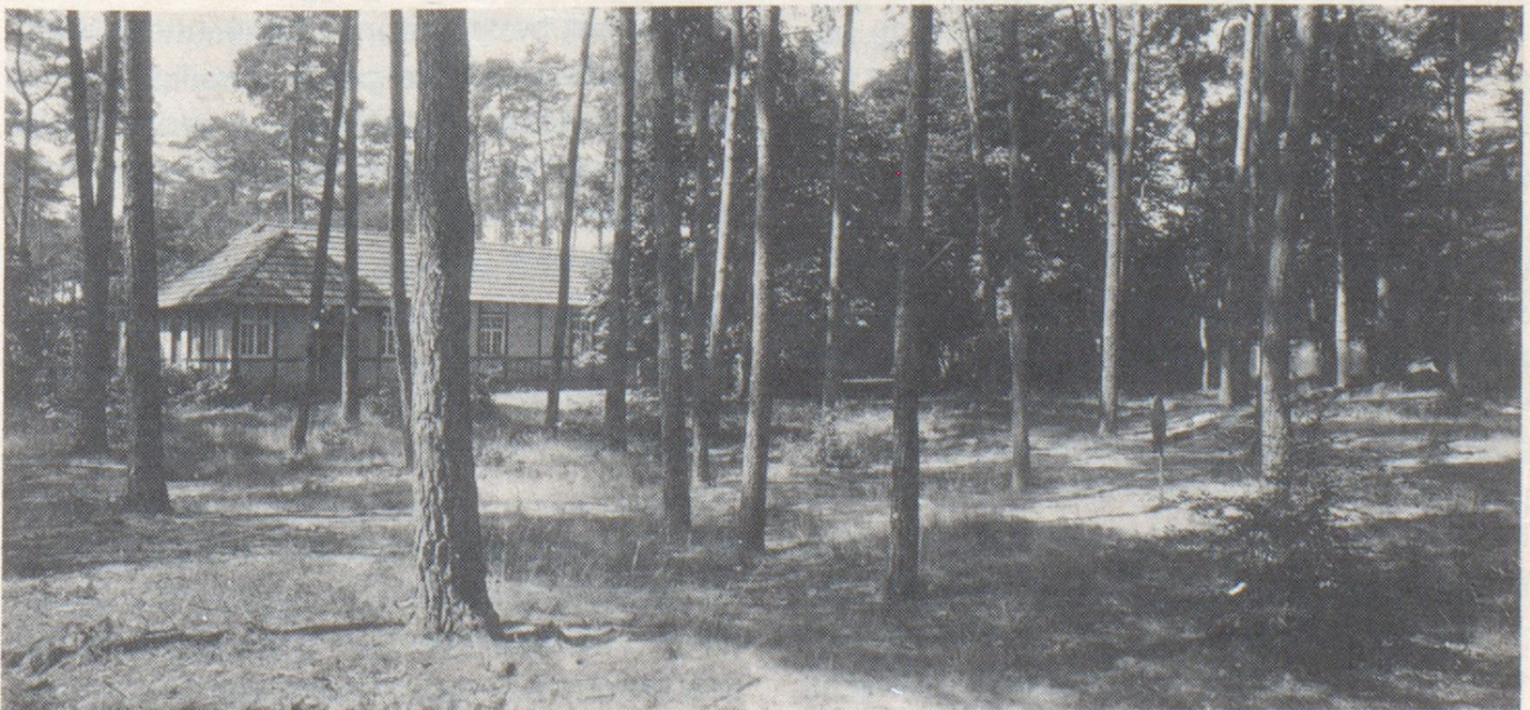
Das Schützenhaus hinter der Gaststätte „Zur Waldeslust“ an der Iggelheimer Straße.
