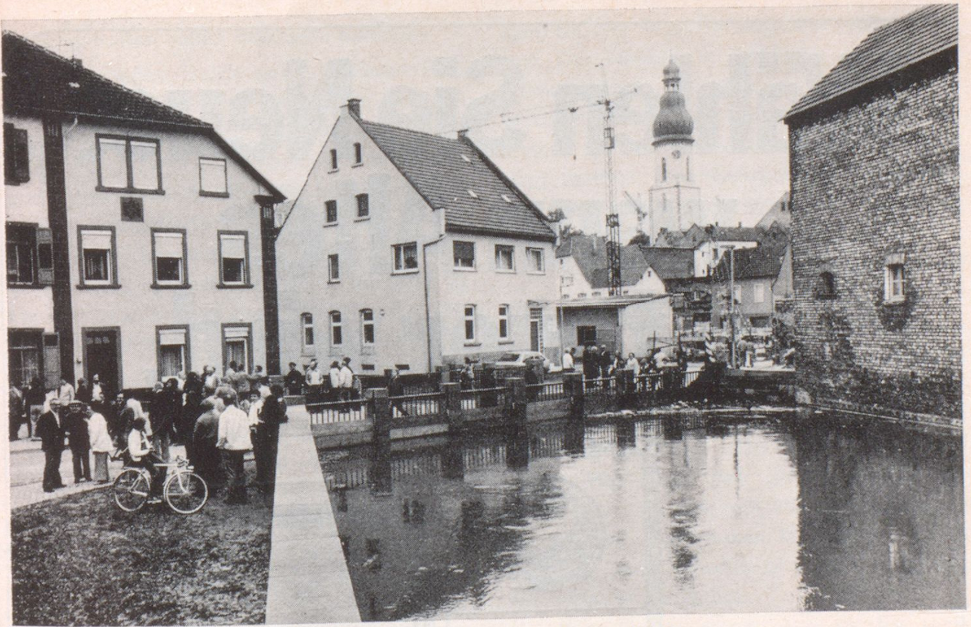
Das Hochwasser an der neuen Salzturmbrücke
