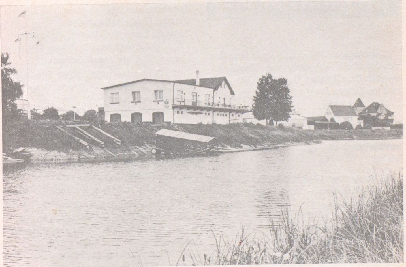
Das Bootshaus der Rudergesellschaft nach dem Umbau im Frühjahr 1978
