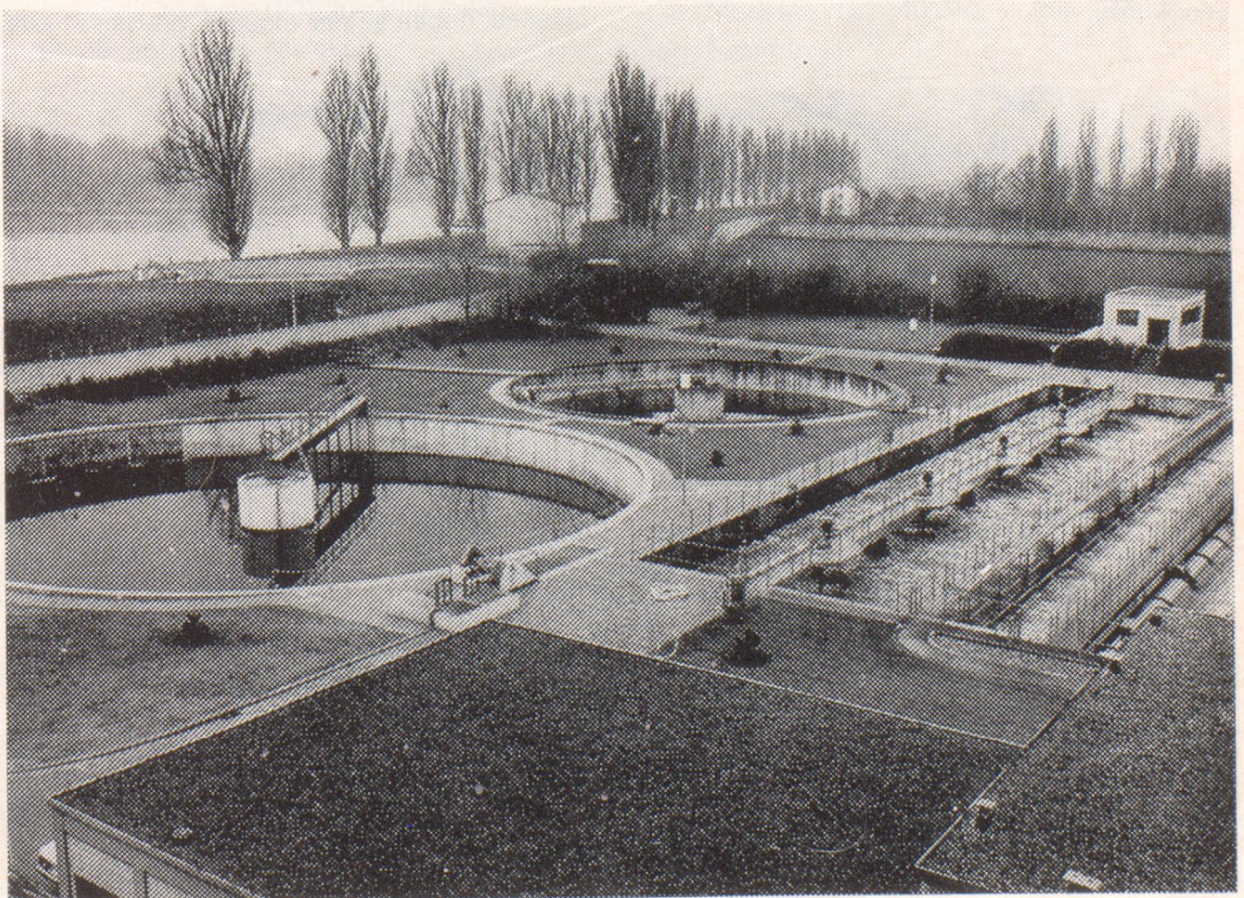
Die Speyerer Kläranlage nach der ersten Erweiterung
