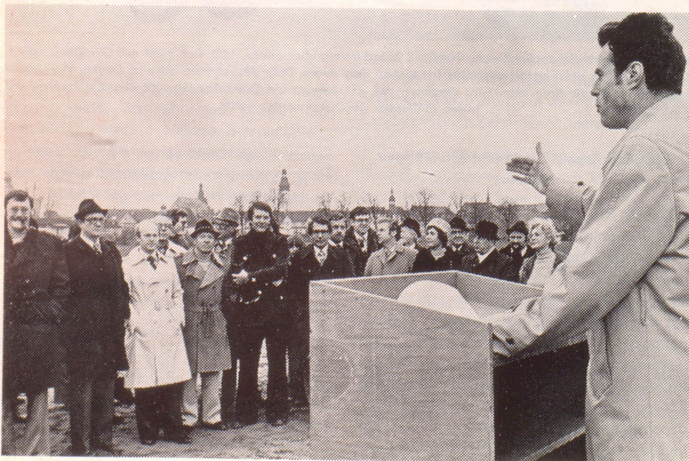
Oberbürgermeister Dr. Roßkopf spricht zu den Versammelten beim ersten Spatenstich für das Schulzentrum Speyer-Ost
