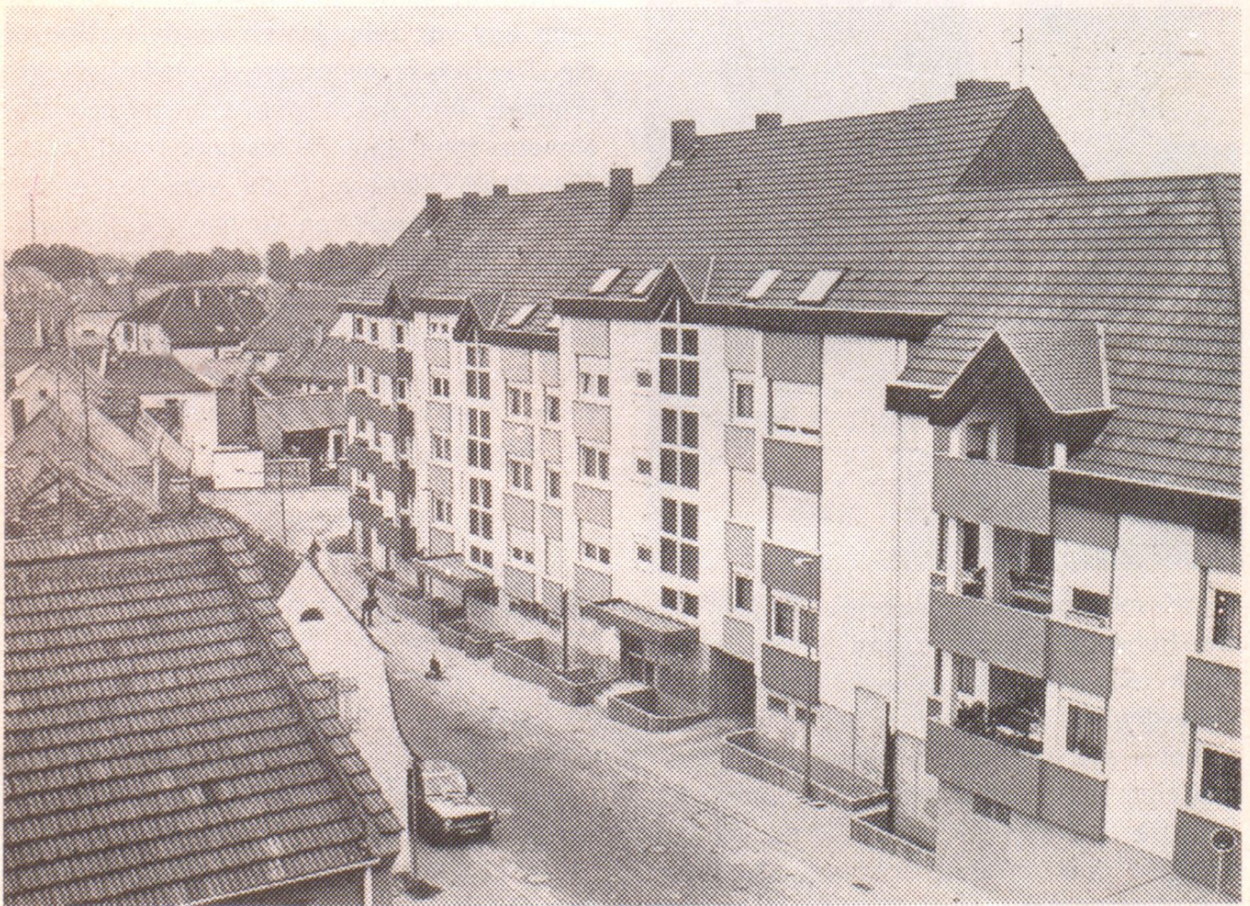
„Fischmarkt I“: Die neuen Gebäude in der Pfaugasse
