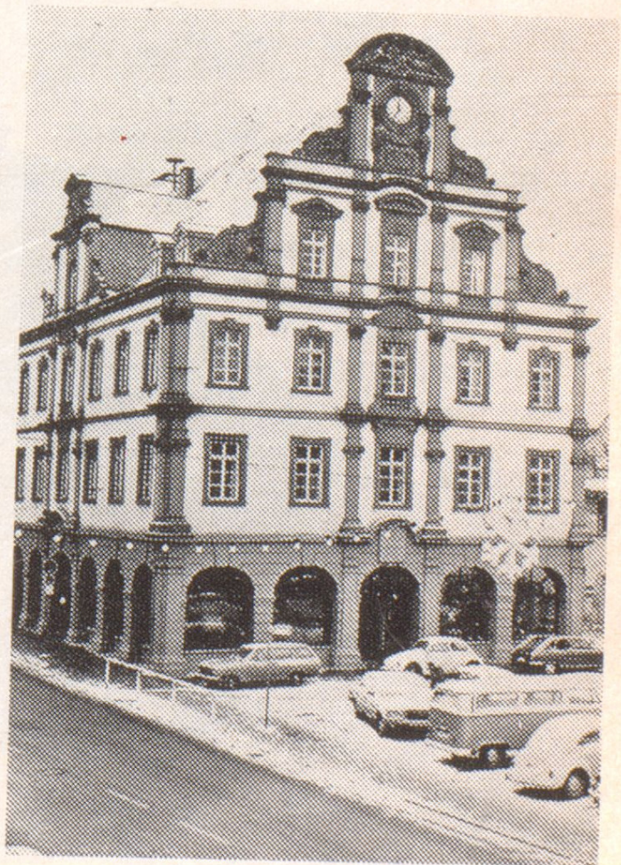
Das ehemalige Kaufhaus nach dem Umbau des Erdgeschosses
