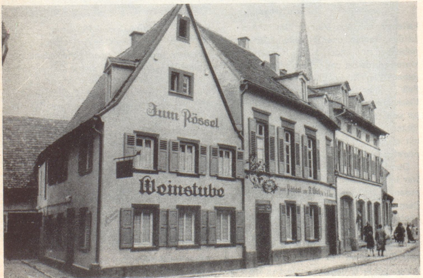
Die Weinstube „Zum Rössel“ vor dem Abbruch
