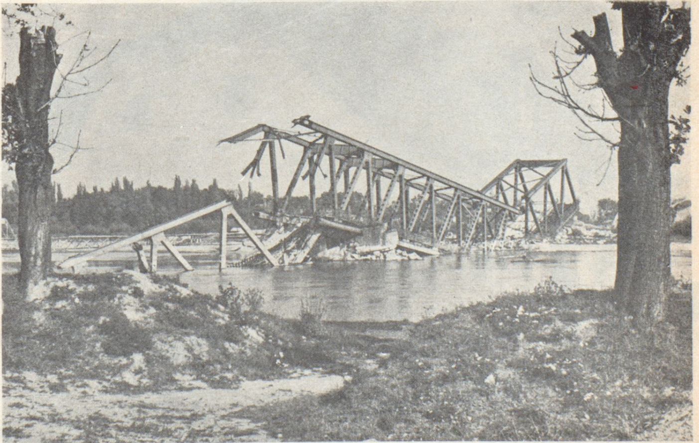
Die gesprengte Rheinbrücke; geknickt lag das mächtige Gitterstahlbauwerk im Strom
