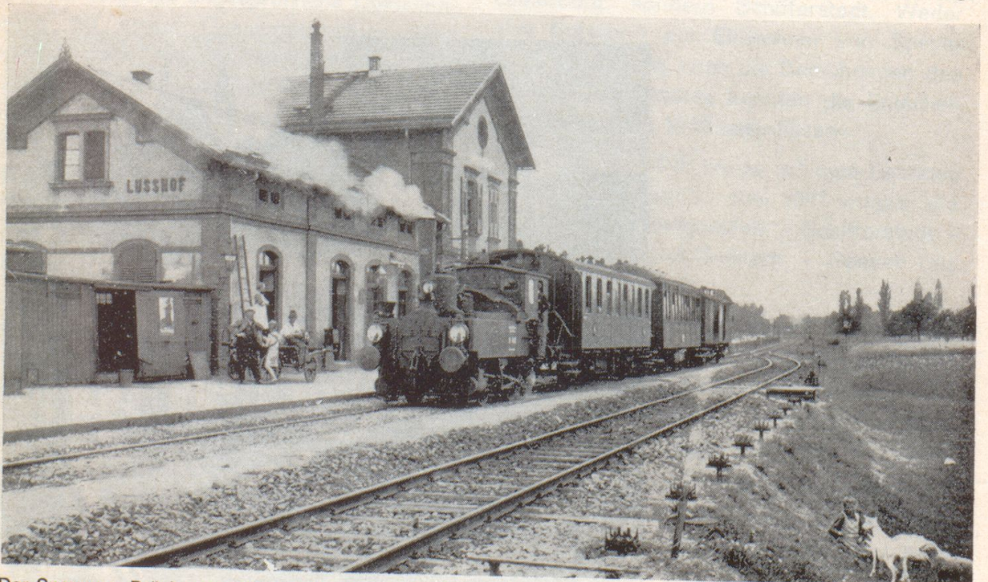
Der Speyerer „Brückenexpress“ vor der Auswechselstation „Lußhof“ auf der badischen Seite. Nur diese kleine Lokomotive durfte über die Brücke, so daß hier bei jedem Zug Maschinenwechsel stattfinden mußte.
