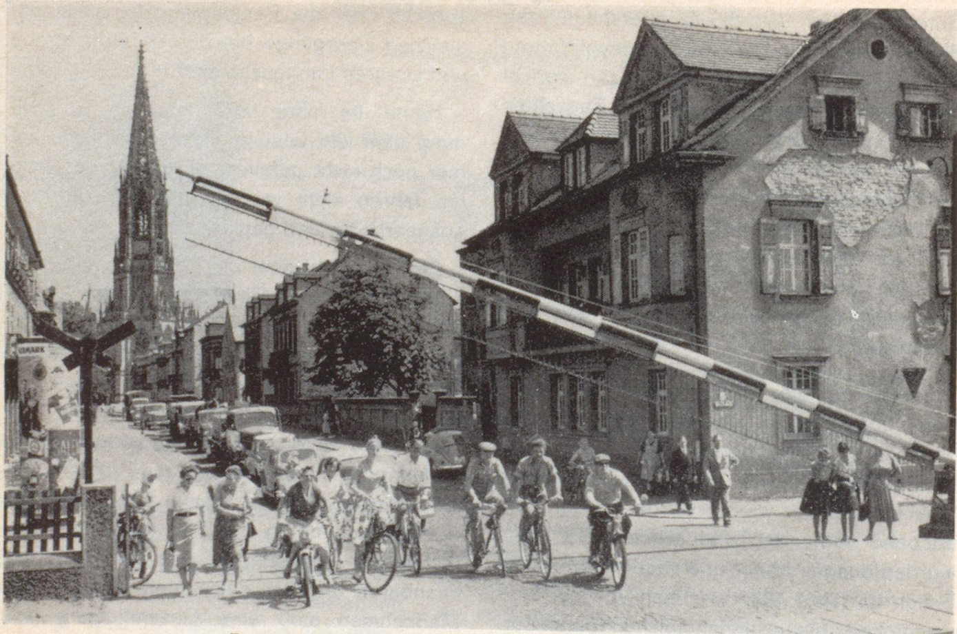
Der schienengleiche Bahnübergang an der Schützenstraße Die Behinderungen des Straßenverkehrs sind heute schon erheblich
