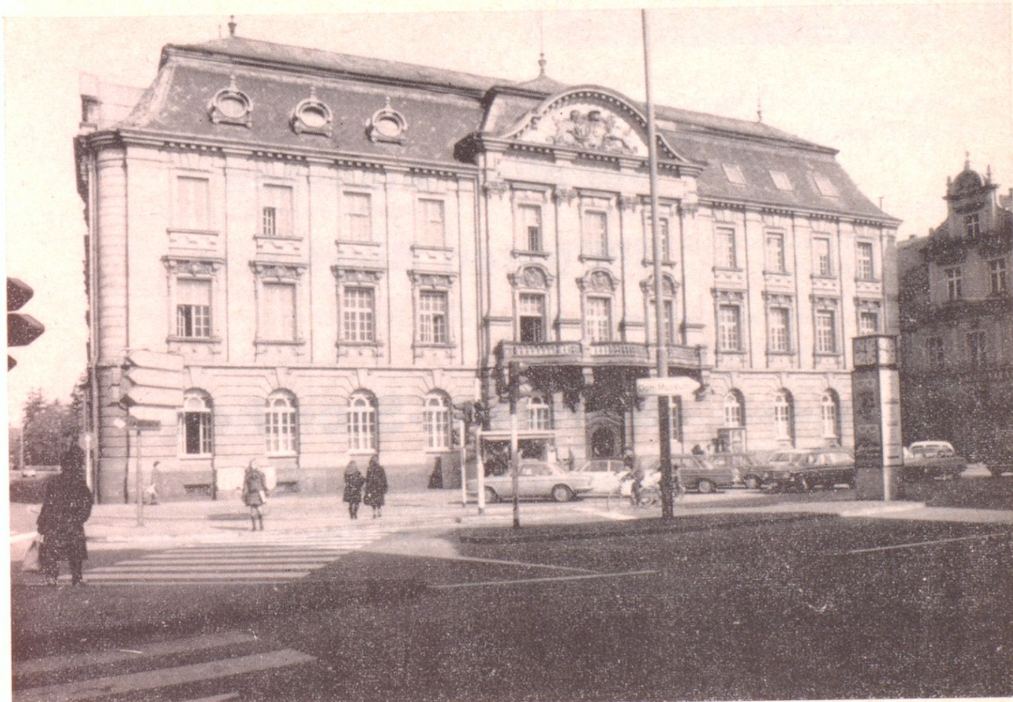
Am heutigen „Postplatz“, dem verkehrsreichsten Knotenpunkt unserer Stadt, wurde in den Jahren 1899–1900 das Verwaltungsgebäude der Oberpostdirektion gebaut
