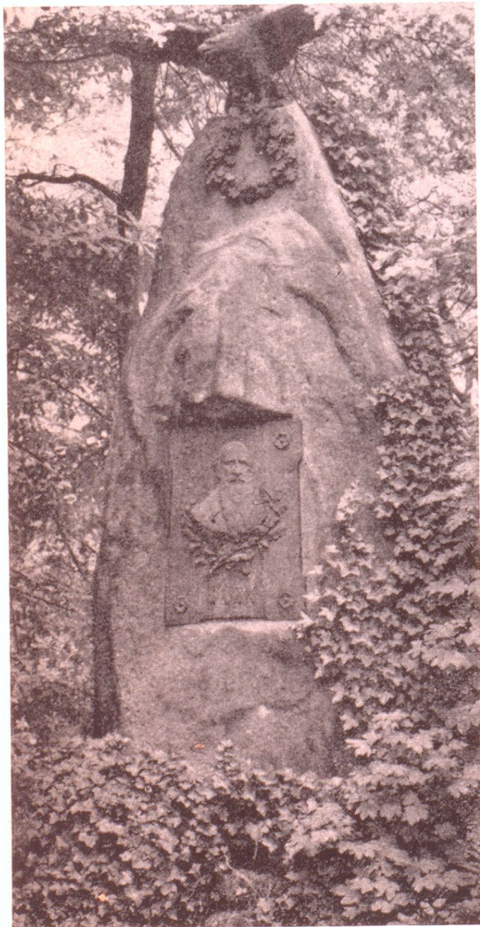
Das Jahndenkmäl vor der Beschädigung
