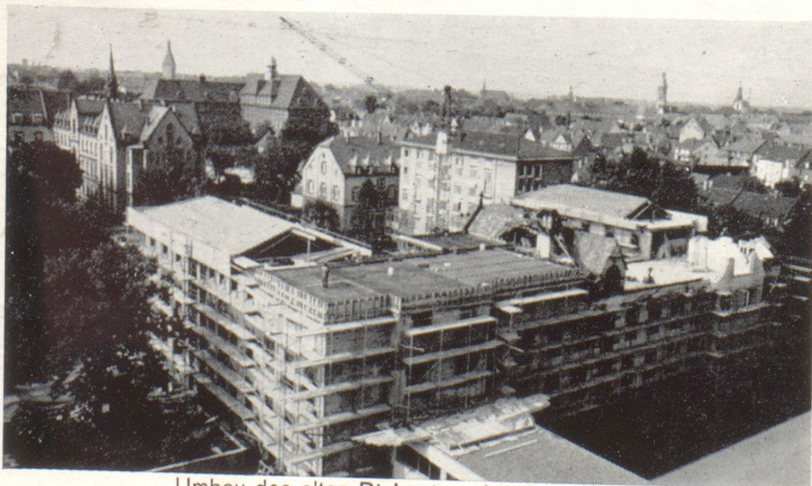
Umbau des alten Diakonissenkrankenhauses
