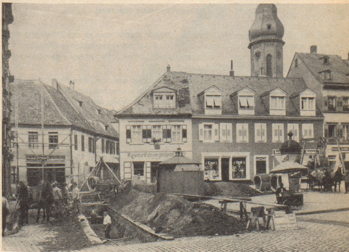
Kanalisationsarbeiten in der Salzgasse (20er Jahre)
