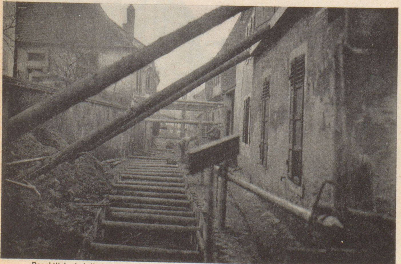
„Beachtlich sind die bei den Arbeitsverfahren notwendigen Sicherungsarbeiten von Gebäuden“, so wie z. B. in der Pistoreigasse
