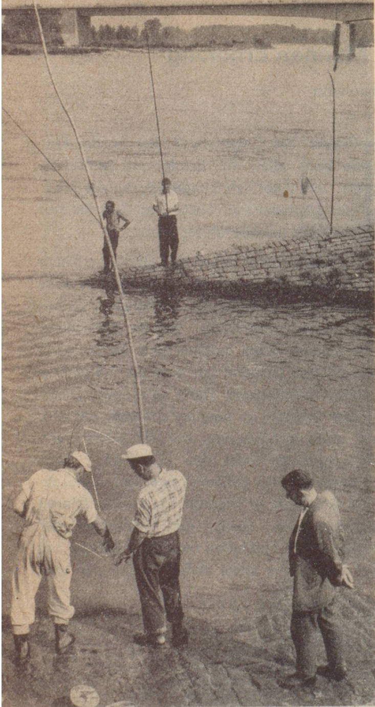
An der Speyerbach-Mündung (im Hintergrund die Rheinbrücke)
