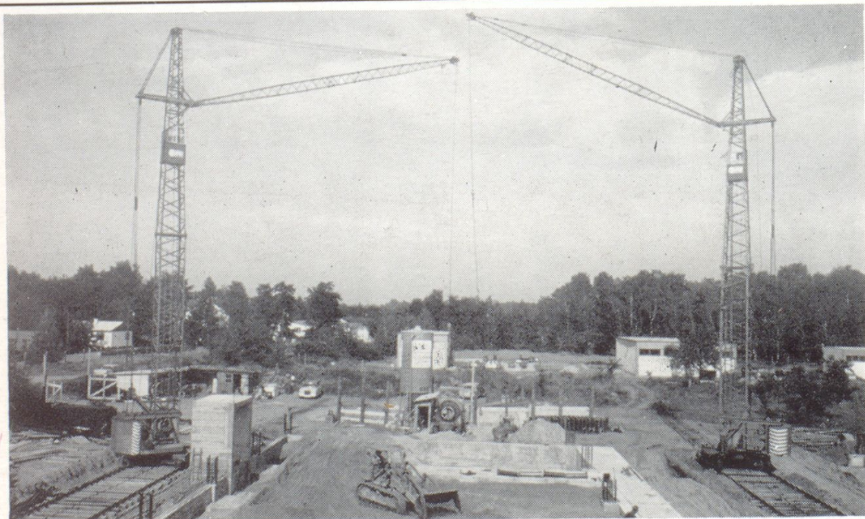
Fundamente für eine Fabrikhalle
