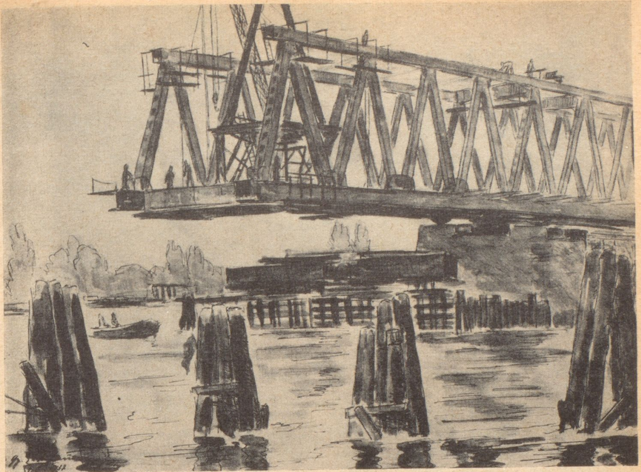
Georg Vorhauer: „Rheinbrückenbau Speyer 1937“ (Aquarell)
