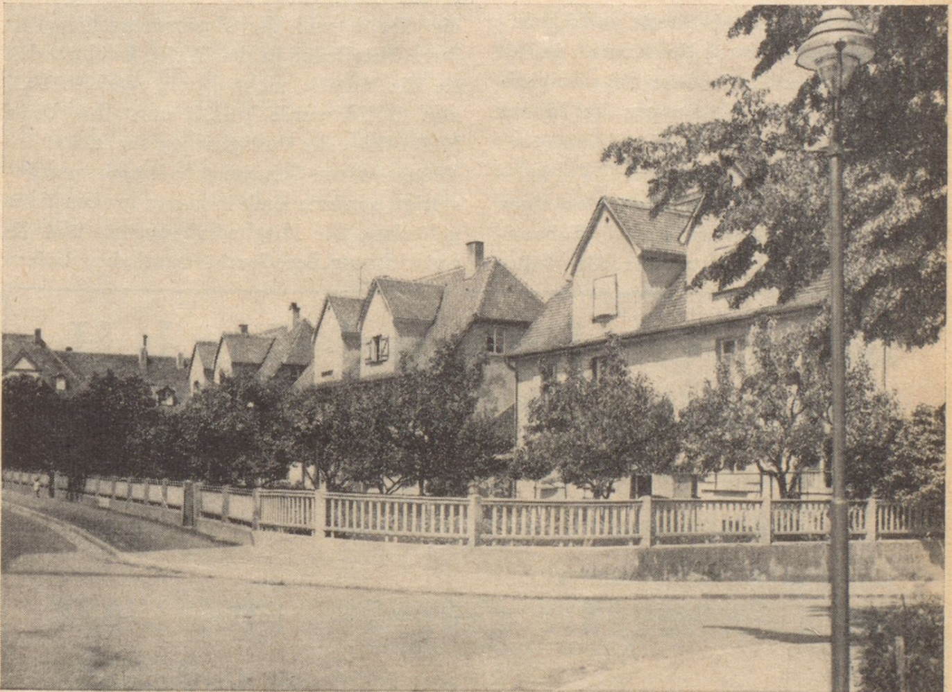
Teil des 1. Bauprogramms der Baugenossenschaft Speyer: 3 Häuser mit 15 Wohnungen in der Blaulstraße, erbaut 1919/20
