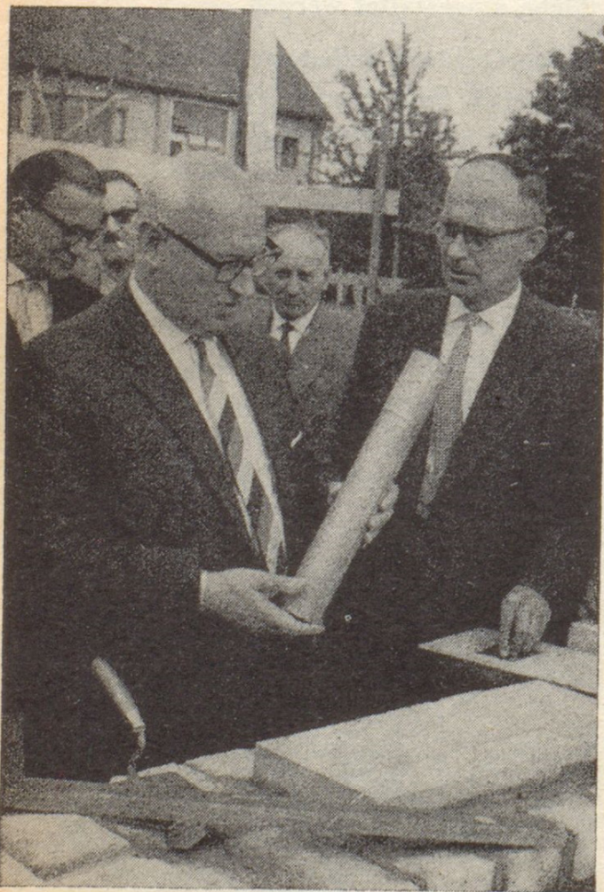
Grundsteinlegung: 23. September 1960 Oberbürgermeister Dr. Skopp (links) und Stadtoberbaurat Hannemann (rechts). Links im Hintergrund Bürgermeister Scherpf.
