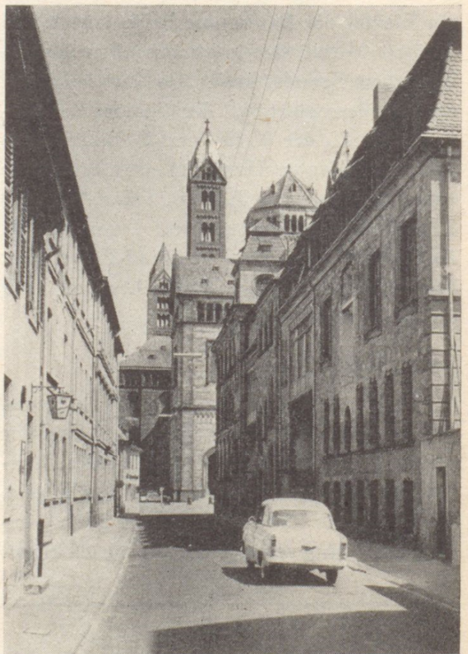
Hier überquerte bis Juni dieses Jahres eine Brücke zwischen den zwei ehemaligen LVA-Gebäuden die Himmelsgasse. Sie wurde abgerissen, nachdem beide Gebäude jetzt neuen Zwecken dienen
